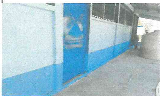
PINTURA INTERIOR Y EXTERIOR DE LA ESCUELA
