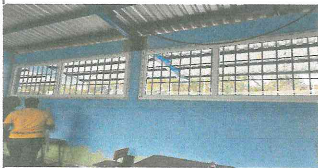
COLOCACION DE VENTANAS DE PVC
