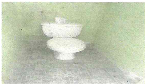
COLOCACION DE BAÑOS SANITARIOS Y PISO ANTIDESLIZANTE
